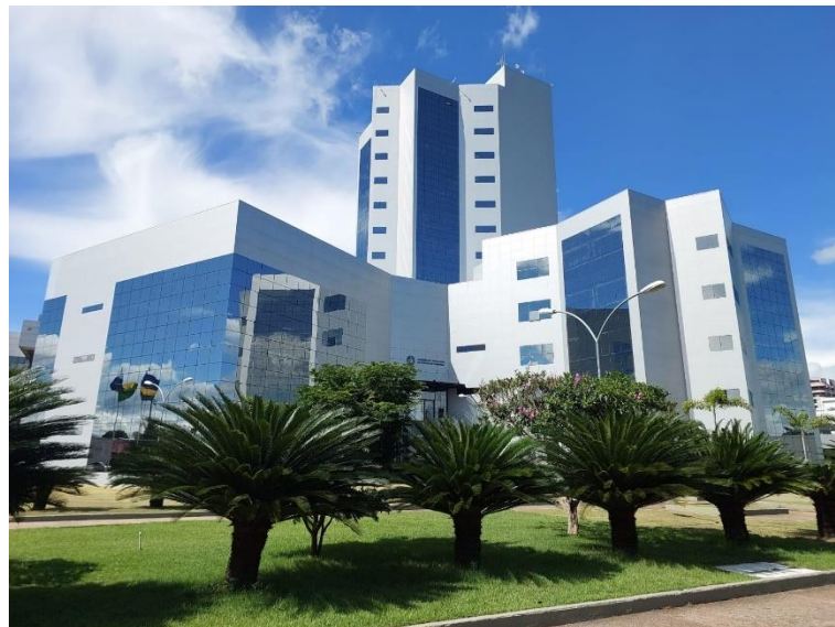
Figura 17 – Fotografia do prédio de estudo
