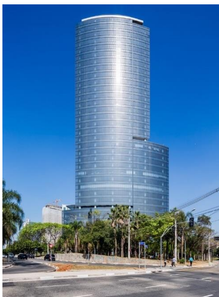
Figura 10 – Prédio da Berrini One , em pele de vidro, em São Paulo.
