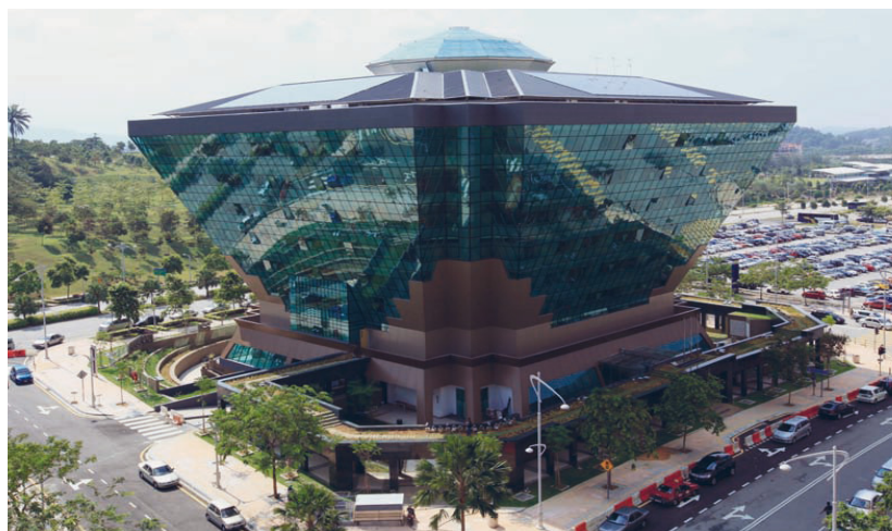
Figura 4.8 – Sistema Solar Fotovoltaico de 71,5 kWp, tipo fachada (IEA/PVSP, 2009)
