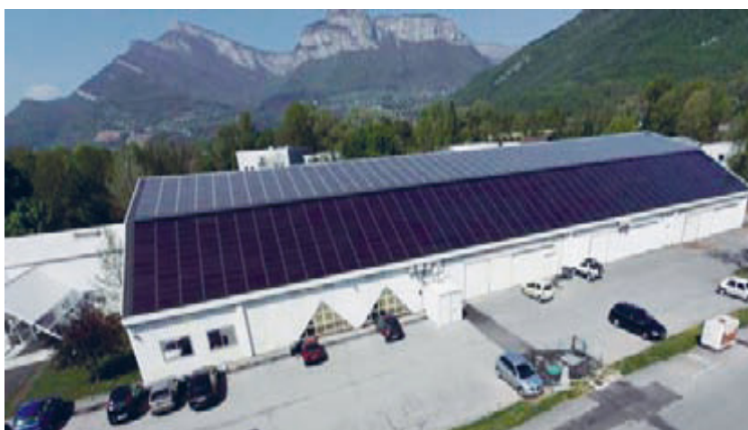
Figura 4.7 – Sistema Solar Fotovoltaico de 203 kWp, tipo telhado (IEA/PVSP, 2009)
