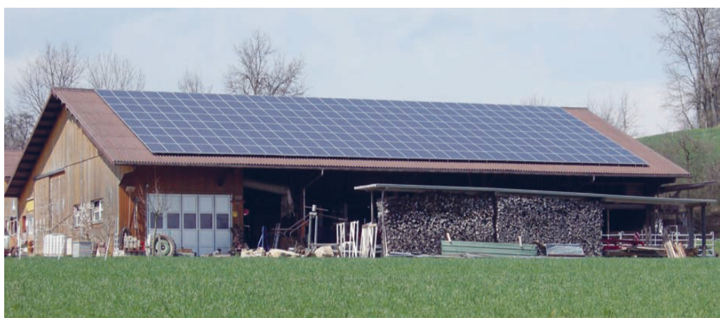
Figura 4.10 - Sistema Solar Fotovoltaico autônomo, off grid , tipo telhado (IEA/PVSP, 2009).
